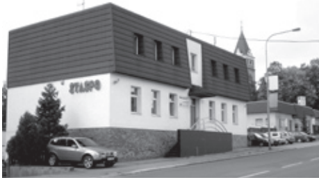
■ Správní budova před a po rekonstrukci
